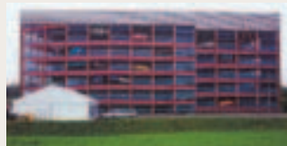
Das neu gestaltete Parkhaus in Thondorf.
