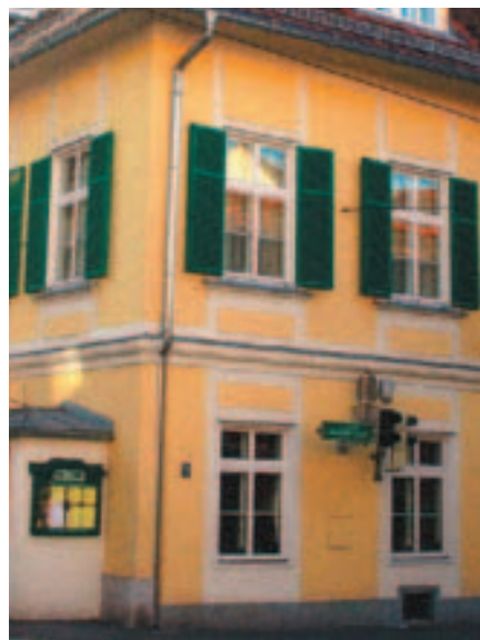
Foto ganz links: Städtisches Wohnhaus Moserhofgasse 17, erbaut 1898, saniert 2007.
