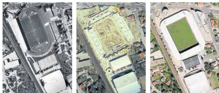
Dokumentiert. Das Stadion Liebenau im Jahr 1989, zur Zeit der Umbauarbeiten 1996 und 2011 (v. l.).
