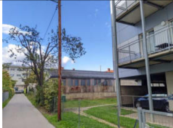
Abbildung 9: Blick auf Bereich Nr. 1, Blick Richtung Norden zur Petersgasse 122
