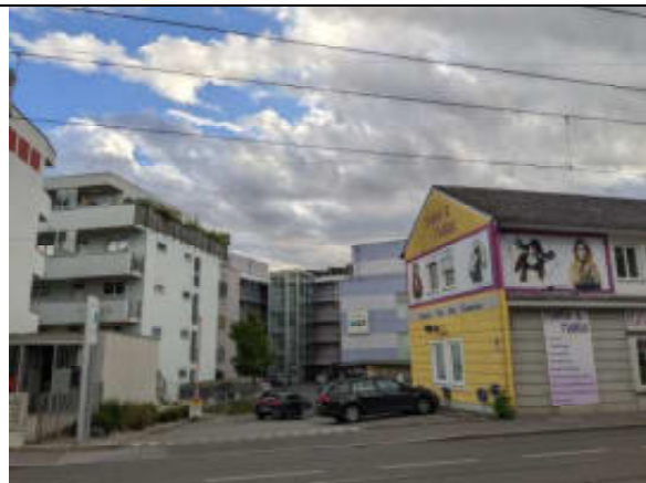
Abbildung 11: Blick auf Bereich Nr. 1, Petersgasse Nr. 126 – Nr. 130 Blick Richtung Süden
