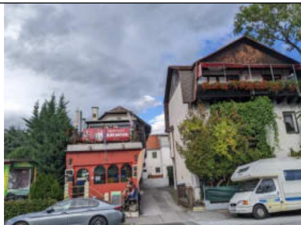
Abbildung 13: Blick auf Bereich Nr. 2, Münzgrabenstraße Richtung Osten
