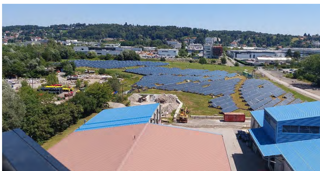
Helios - solares Speicherprojekt Neufeldweg Graz - Gesamtansicht 1., 2. und 3. Bauabschnitt
