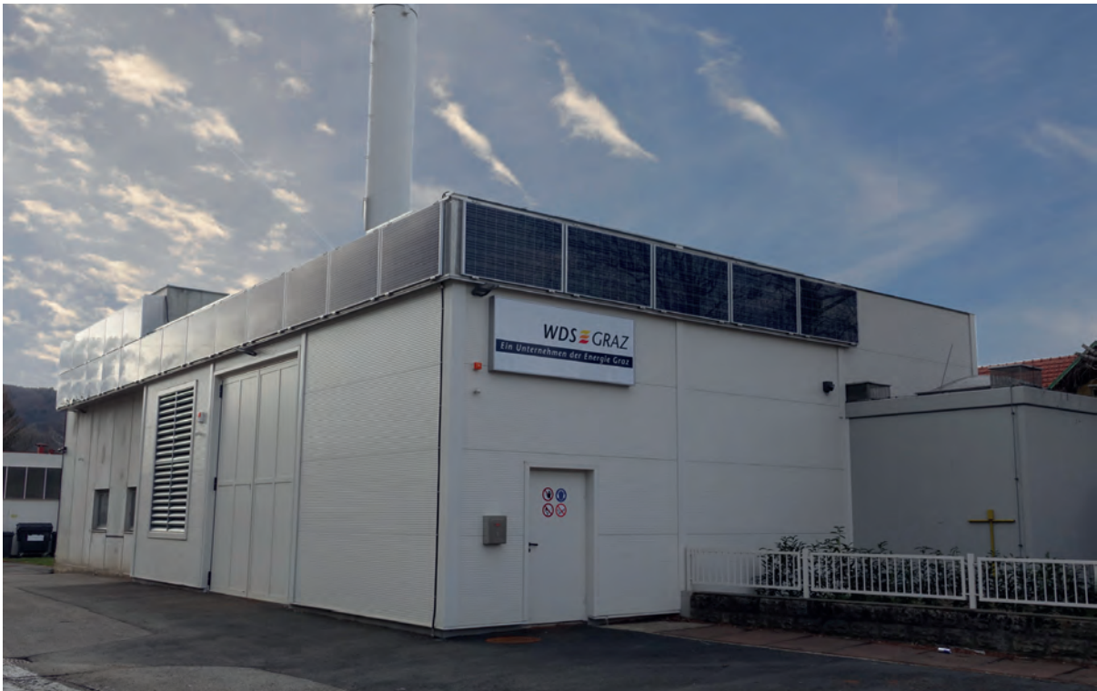
WDS Heizzentrale Waagner-Biro-Straße
