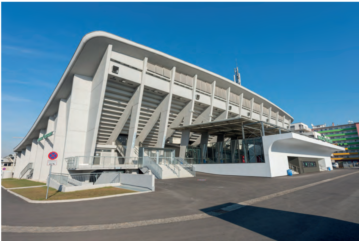
Eishalle Graz Liebenau
