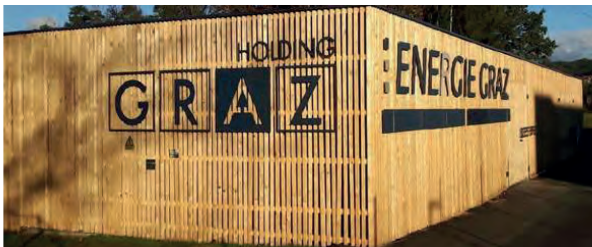
Übergabestation Fernwärme-Transportleitung Sappi in Graz Andritz
