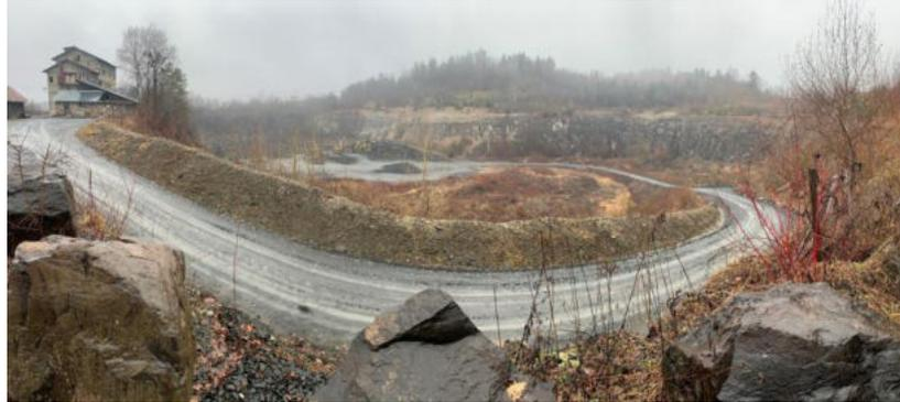
Speicher: Basaltsteinbruch mit 7,5 ha Fläche und einer Tiefe von ca. 40 Metern (ca. 1,5 Mio. m<sup>3</sup> Wasser)
