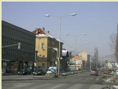
Reflektortechnik 1960 Leuchten ohne Nachtabsenkung 250W
