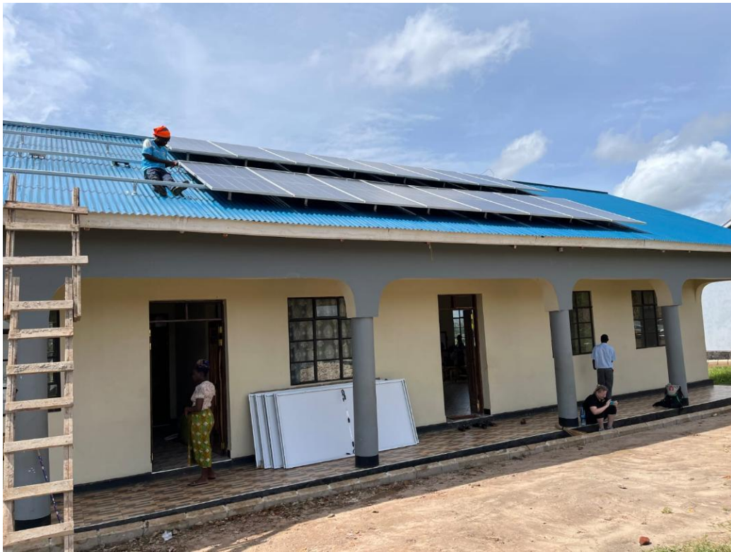
Bau der Photovoltaik-Anlage, ASA JUA, TANSANIA
